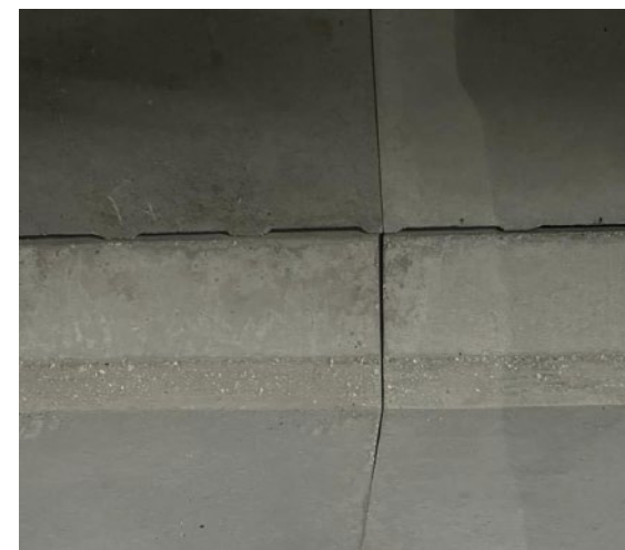
Interior refractory concrete Innenverkleidung Feuerfestbeton
